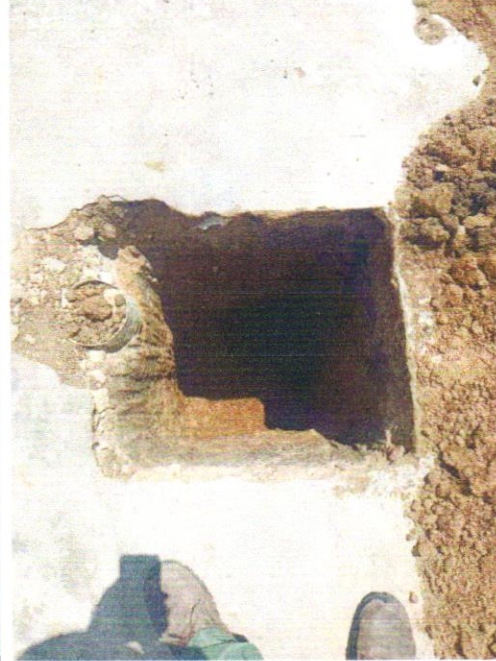
ESCAVAÇÃO MANUAL PARA SAPATA ISOLADA
