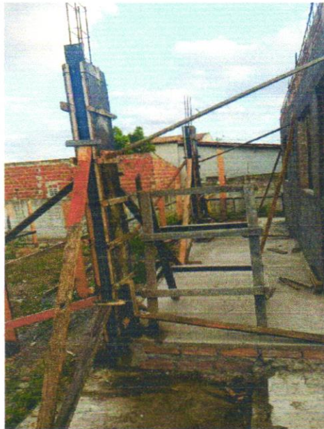
MONTAGEM E CONCRETAGEM DE PILARES
