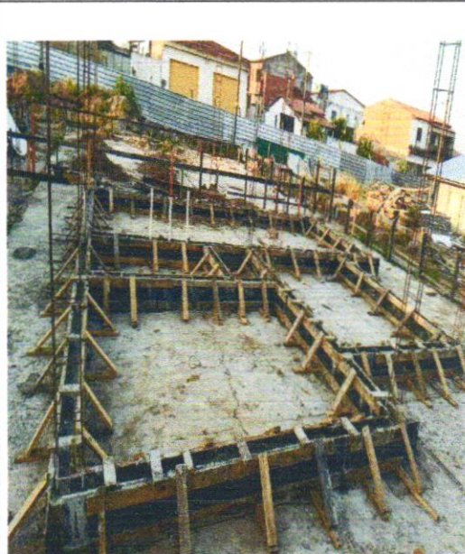
MONTAGEM E CONCRETAGEM DE BALDRME
