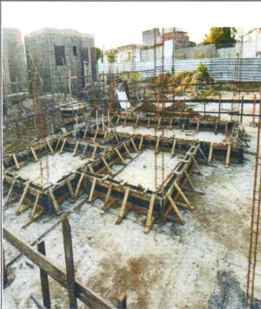
MONTAGEM E CONCRETAGEM DE BALDRME
