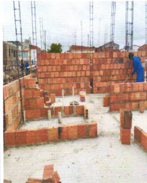
LEVANTE DE ALVENARIA
