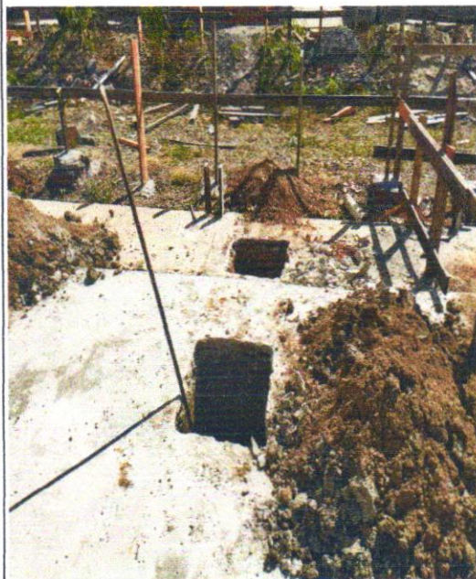
ESCAVAÇÃO MANUAL PARA SAPATA ISOLADA
