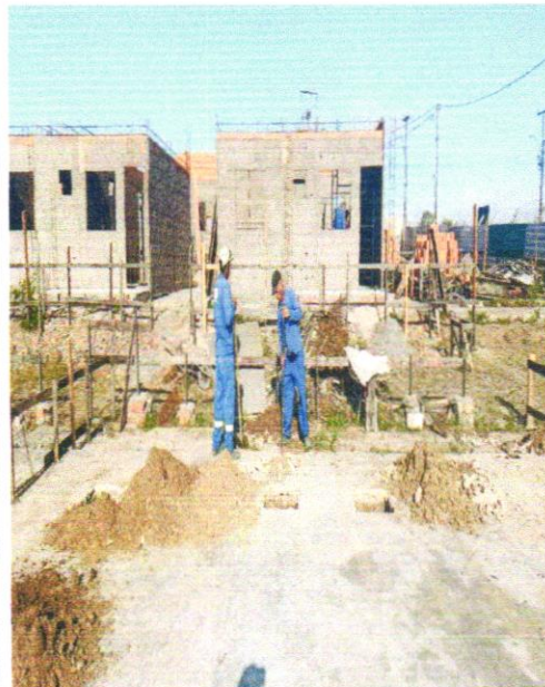
ESCAVAÇÃO MANUAL PARA SAPATA ISOLADA
