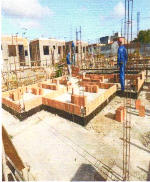
LEVANTE DE ALVENARIA
